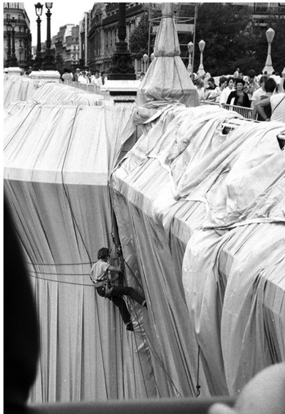
Acrobatie : travaux en spectacle
